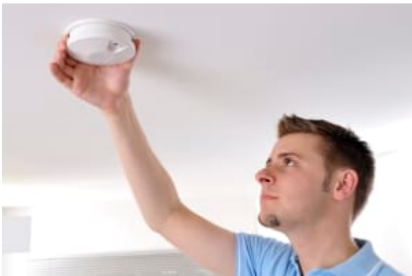
Rauchmelder sollen regelmäßig gemäß Herstellerangaben geprüft werden, mindestens alle zwölf Monate (Foto: VöV).
