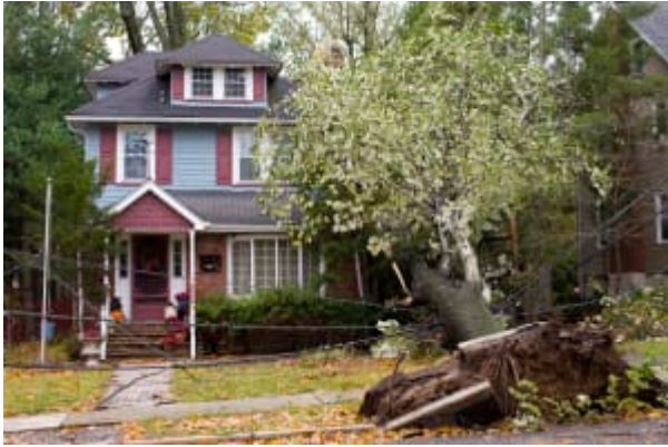
Entwurzelte Bäume können Häuser, Einrichtung und Nachbargrundstücke schwer beschädigen. (Foto: iStock / Chris Sadowski)
